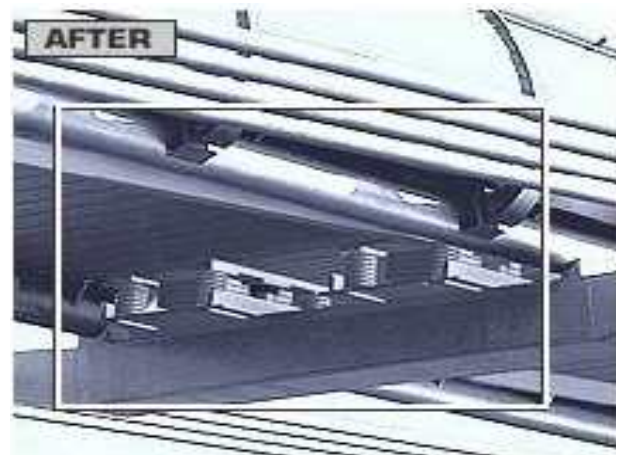
시공사례2. 영국 밀레니엄 브리지 [TMD 장치]
